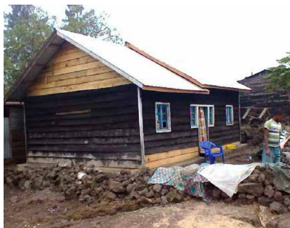
Casa construïda per a una família en situació de vulnerabilitat.
