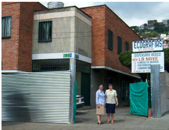
Centre Mèdic María Gay La Nave, Cali (Colòmbia).
