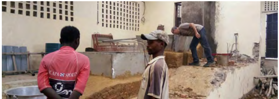
Instal·lacions de la “Sucrera de Sant Josep”.
